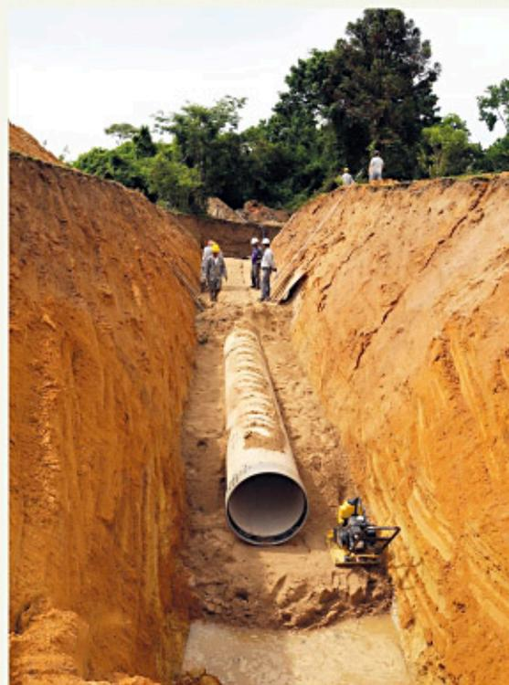
Em 2009, foi iniciada a construção do interceptor de esgoto da margem direita do Rio Jundiá, para cumprir a meta de coletar e tratar 100% do esgoto da cidade. Na foto, trecho da 2ª fase da obra que está sendo executada.
