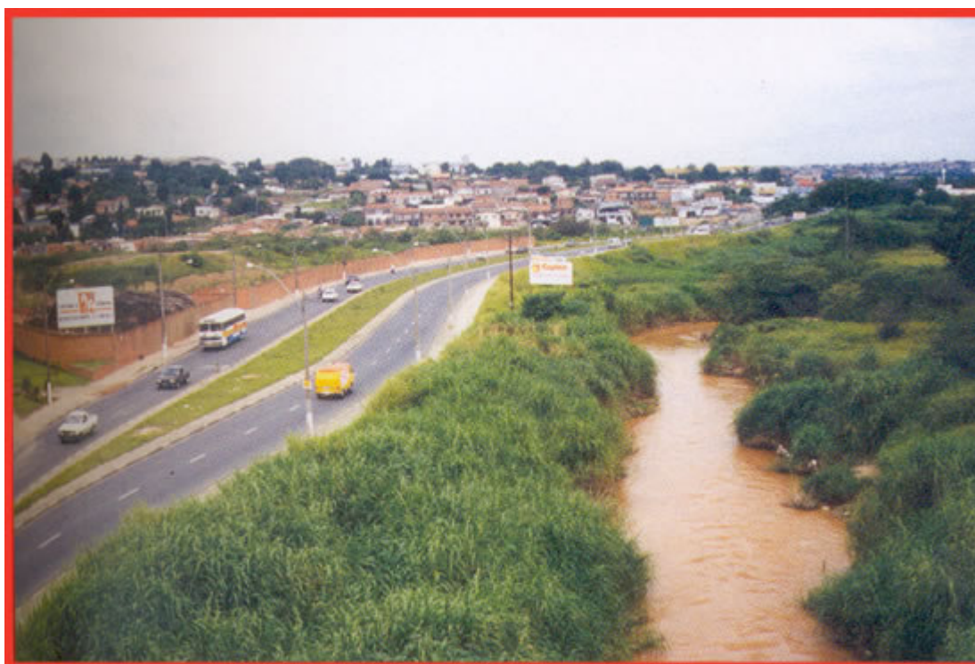
Córrego do Piçarrão
